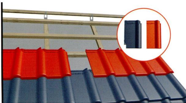
Uložiť riadok škridiel - pod plánovaným miestom montáže komínka. Uložiť minimálne po troch škridlách na ľavej a pravej strane miesta montáže komínka Virtum®UNI. Odporúča sa odrezať bočný zámok v škridle, ktorá sa nachádza na pravej strane konzoly.
