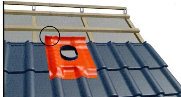
Po vhodnom vyprofilovaní bokov a spodnej časti prírubi ju stastostivo prilepíme na strešnú krytinu začínajúci od konzoly smereom vonku (nabok a dolu). Okraj je treba stlačiť napr. pomocou strechárskeho pritlačovacieho valčeka. V prípade keramických škridiel (odrezať zvyšnú časť (kolidujúcu s horným zámkem škridly).
